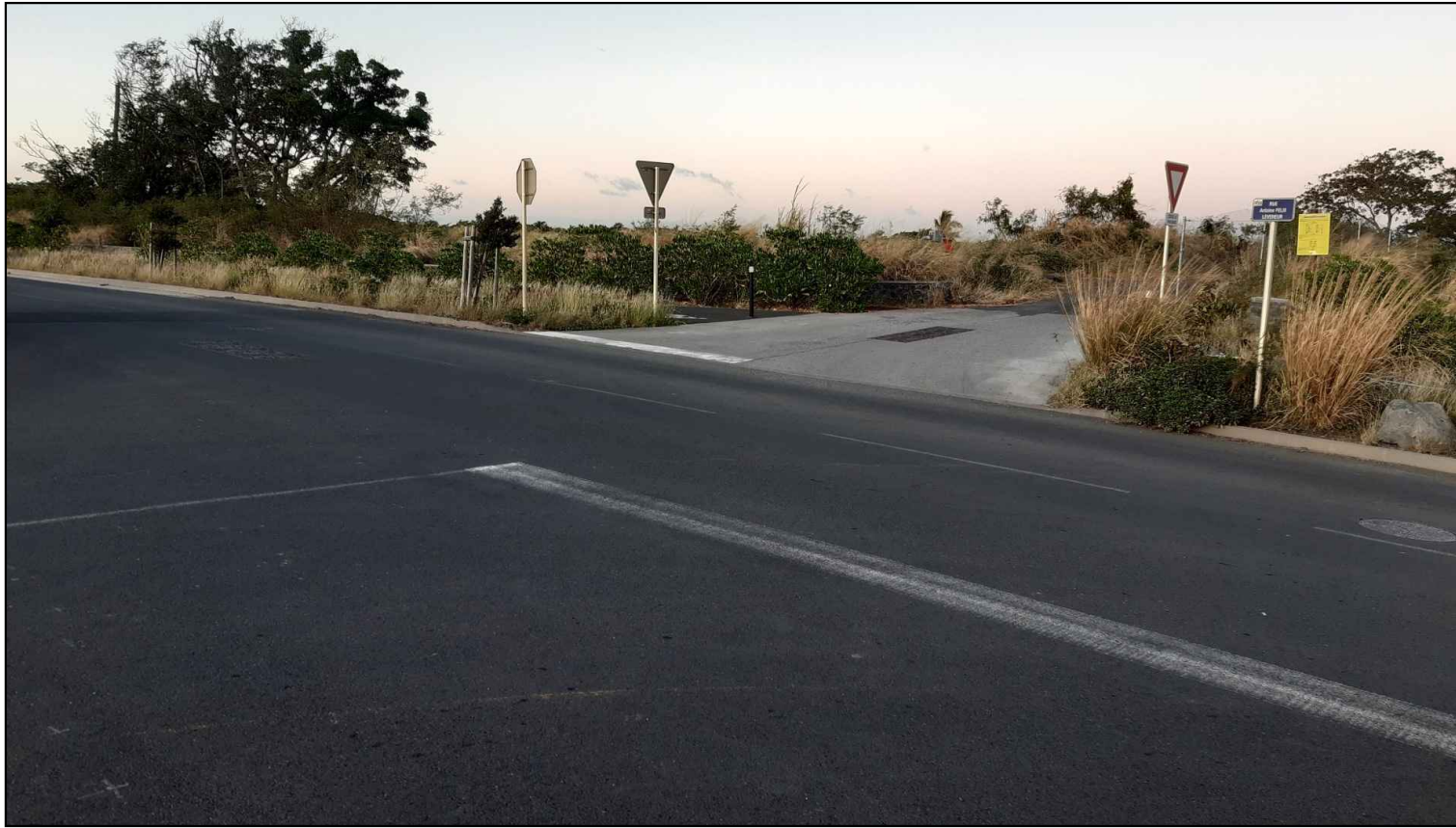
Intersection existante (mai 2022) entre le chemin Grands Fonds au et la rue Antoine Félix LEVENEUR
